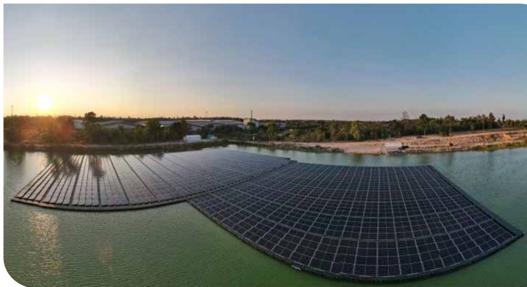
ระบบผลิตไฟฟ้าพลังงานแสงอาทิตย์ (Solar Floating) แบบติดตั้งแบบลอยน้ำที่โรงงานยางแท่ง สาขามุกดาหาร
