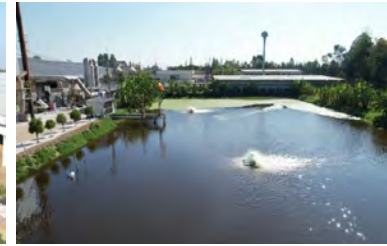
บ่อบำบัดน้ำเสียบ่อดกตะกอน
