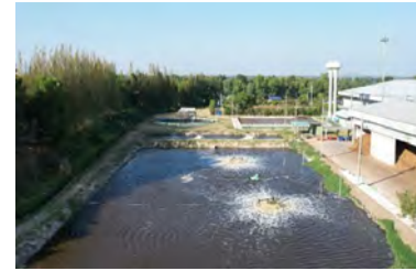
ระบบบำบัดน้ำเสียแบบบ่อดกตะกอน
