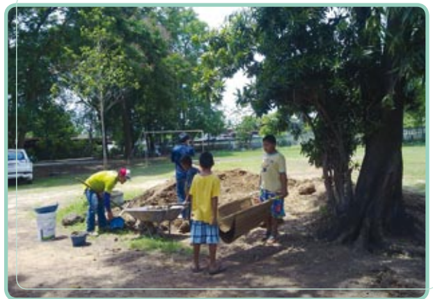
นักเรียนและพนักงานร่วมกันขุดดินเพื่อปรับปรุงพื้นที่หอสมุด
